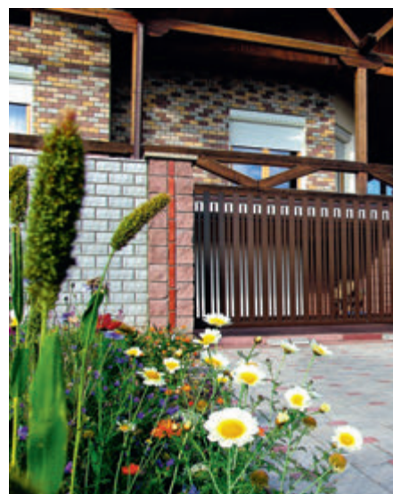
Разреженное заполнение алюминиевым профилем
