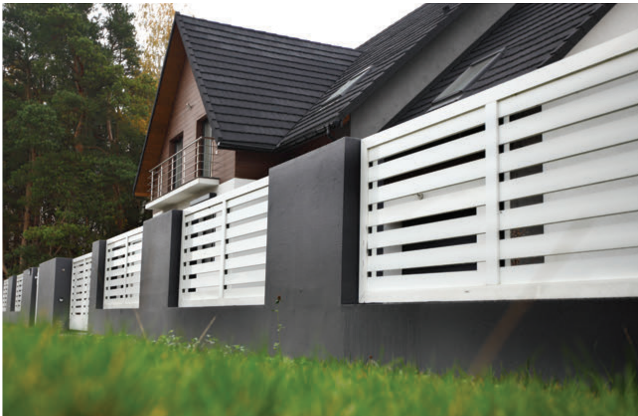
Разреженное заполнение алюминиевым профилем
